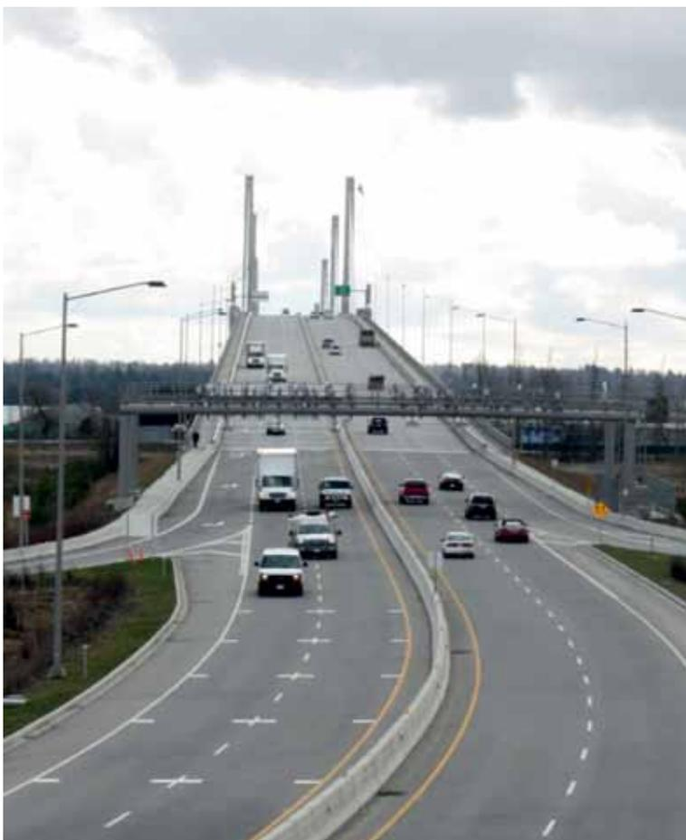
Photo 1 : **Portique de paiement du pont Golden Ears à Vancouver**
